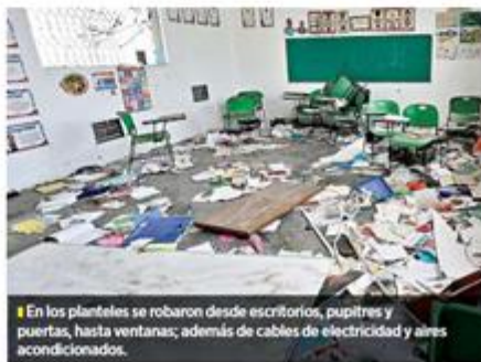
La Primaria María W. Benavides y el Jardín de Niños Eulalio González Ramírez, que están contiguos, muestran daños y abandono.
